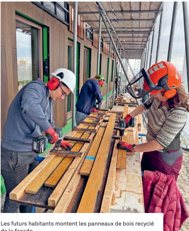
La façade en bambou et panneaux de bois recyclé.
