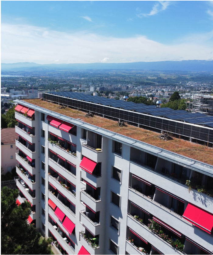
SCHL, Boisy: Façade rénovée Photo: SCHL
