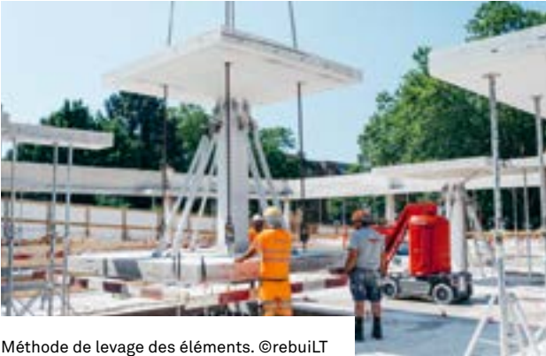
Méthode de levage des éléments. ©rebuILT
