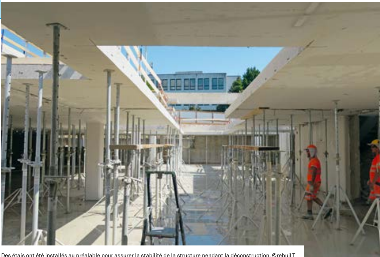
Des étais ont été installés au préalable pour assurer la stabilité de la structure pendant la déconstruction. ©rebuilT
