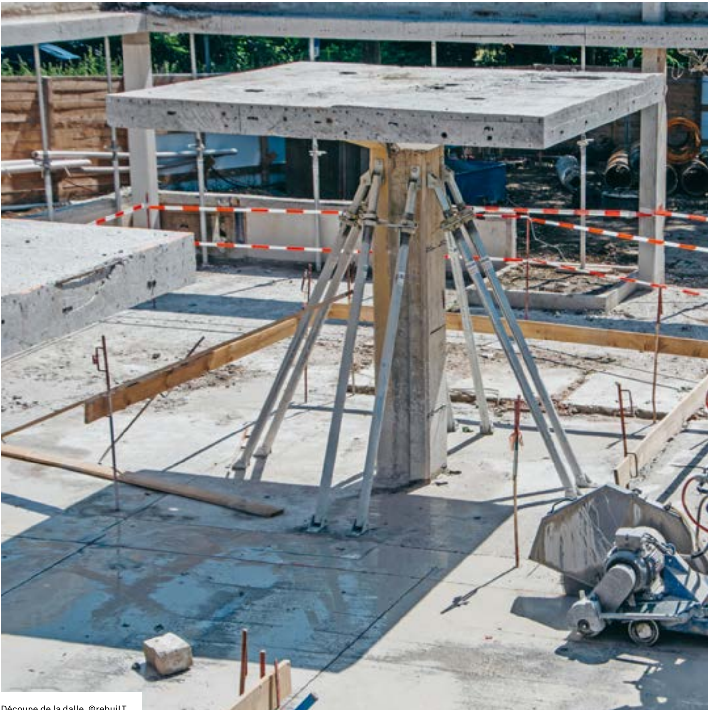
Découpe de la dalle. ©rebuILT
