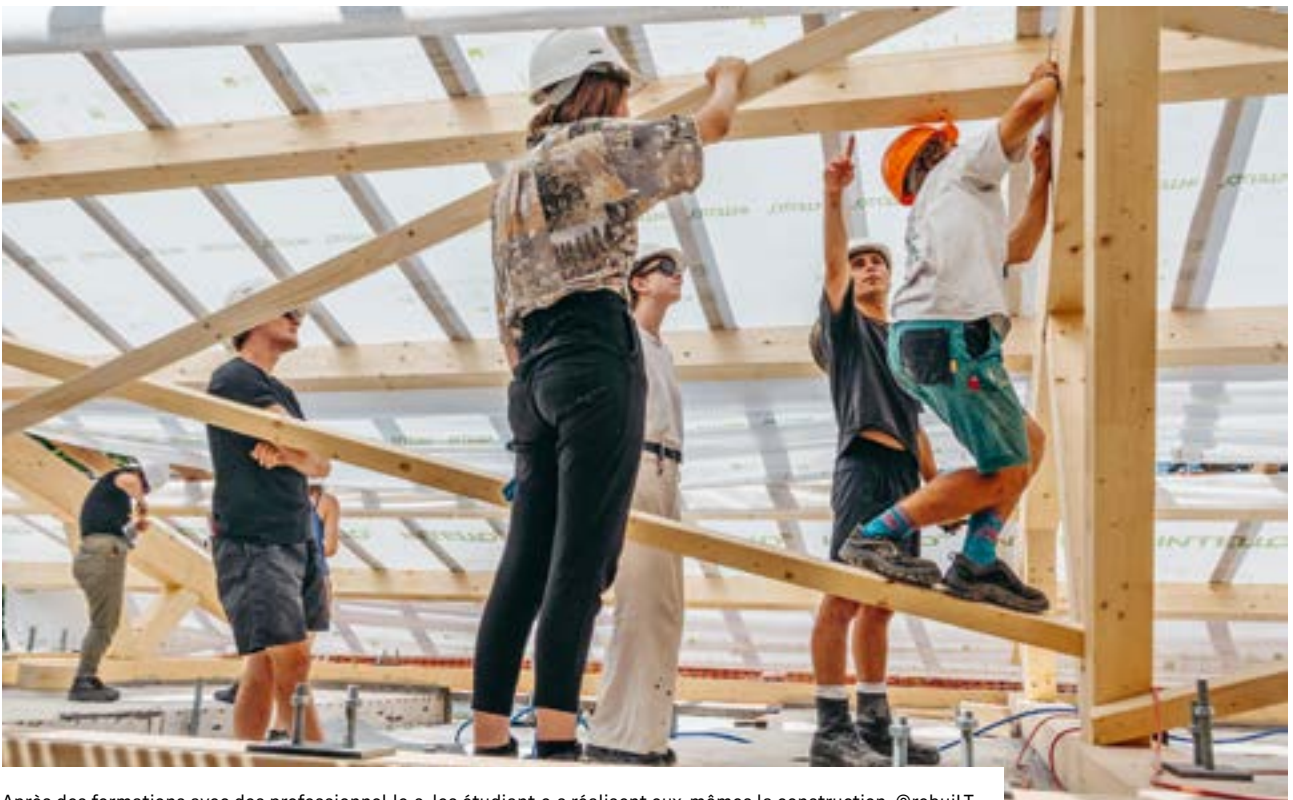
Après des formations avec des professionnel-le-s, les étudiant-e-s réalisent eux-mêmes la construction. ©rebuILT
