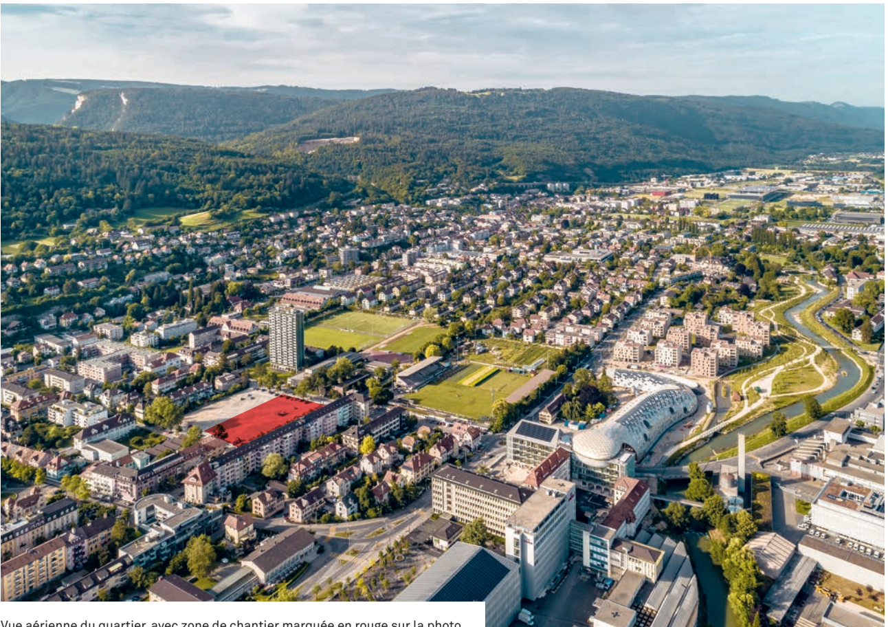
Vue aérienne du quartier, avec zone de chantier marquée en rouge sur la photo.
