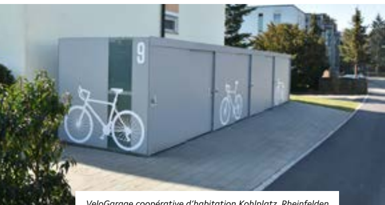
VeloGarage coopérative d'habitation Kohlplatz, Rheinfelden
