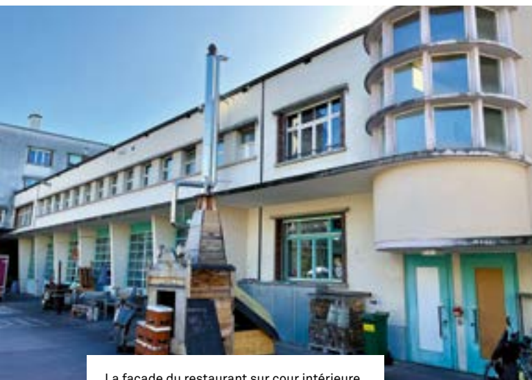
La façade du restaurant sur cour intérieure.
