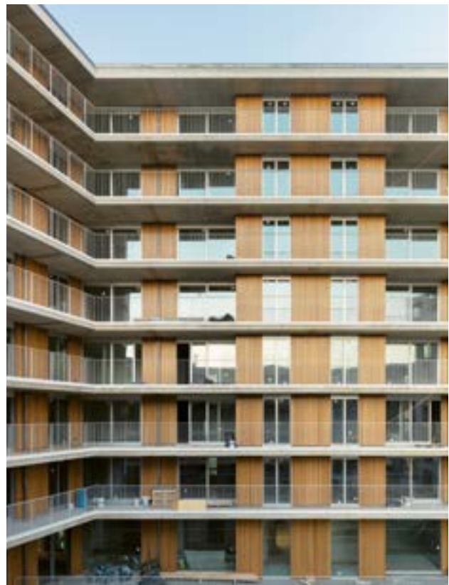
Les coursives extérieures marquent les façades donnant sur la cour et offrent une lecture unitaire du bâtiment.
