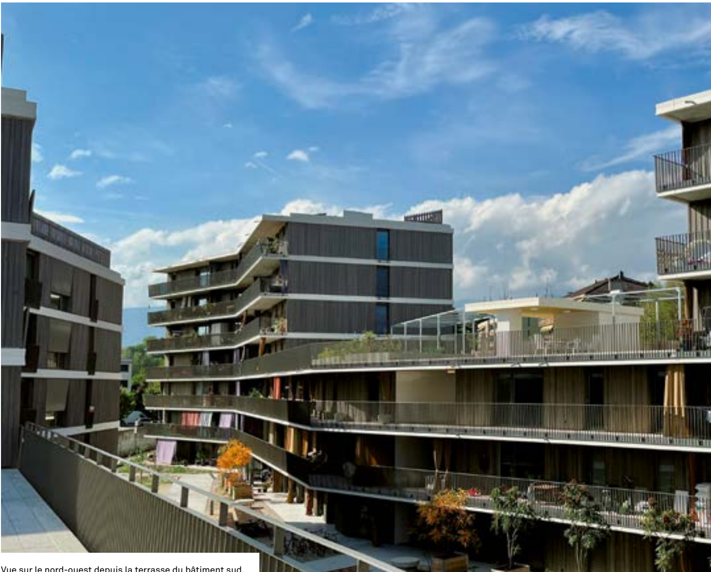
Vue sur le nord-ouest depuis la terrasse du bâtiment sud.
