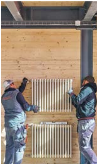
K118: montage de radiateurs récupérés dans l'ancienne imprimerie de Winterthur. Photo: Martin Zeller
