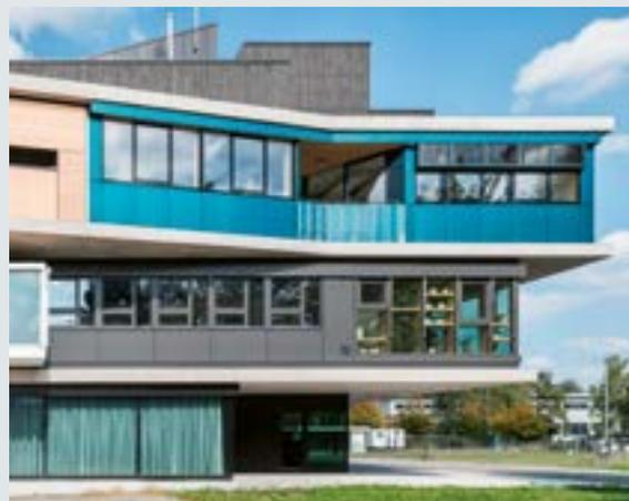
*Façade sud de l'unité SolAce au NEST à Dübendorf équipée de panneaux solaires photovoltaïques colorés (Kromatix) / Lutz Architectes, EPFL. © Roman Keller*
