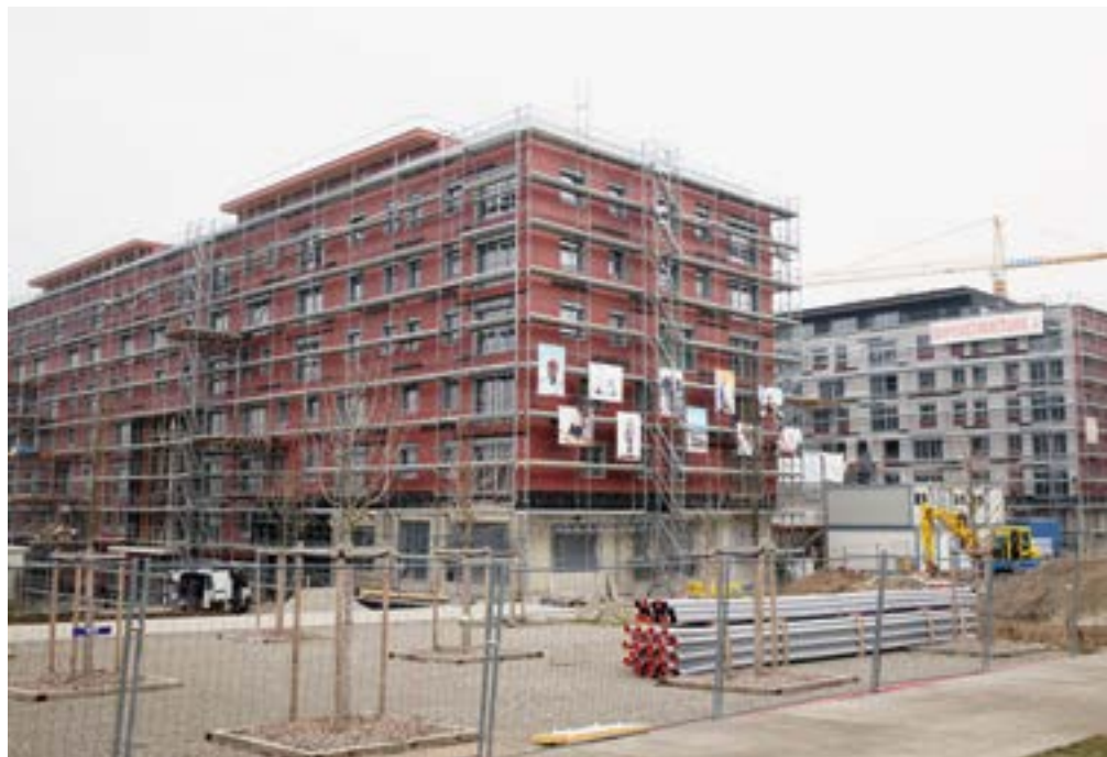
Pour ce bâtiment hybride (Les Vergers à Meyrin), la structure porteuse est en béton et les éléments de façade sont à ossature bois, de même que les attiques. © Bellmann, bureau d'architectes, Montreux
