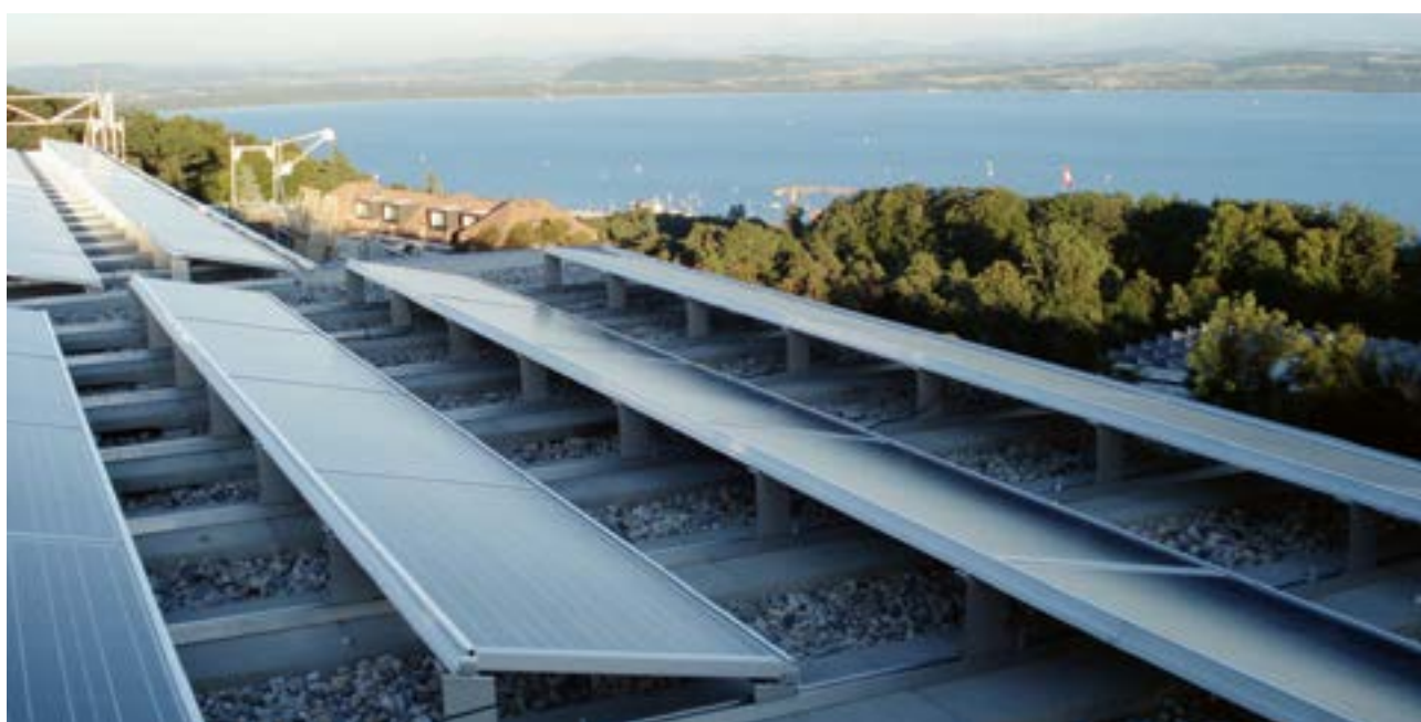
Le toit de l'immeuble des Acacias est recouvert de panneaux solaires photovoltaïques et thermiques depuis 2010. © Coopérative Les Rocailles
