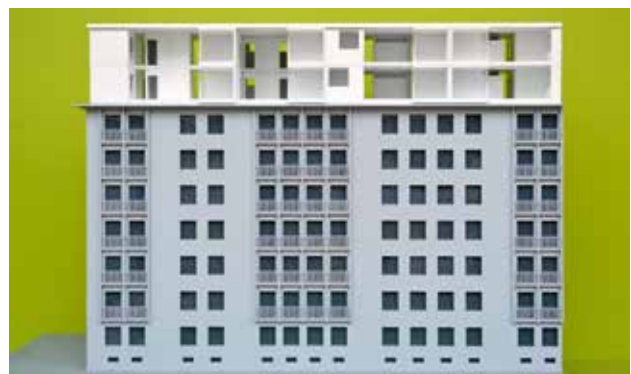
Maquette montrant le montage des éléments 2D de toiture
