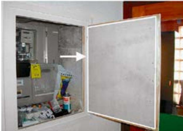
*L'amiante permettait notamment d'isoler les portes des tableaux électriques.*
