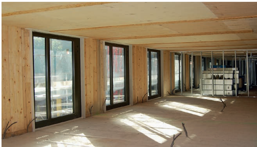
Le gros œuvre est terminé et les étages sont divisés en appartements, au moyen de parois en construction à sec et de cloisons de doublage, avant d'être aménagés.
