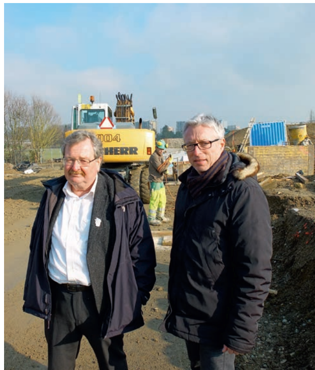
Petit tour sur le chantier. ©PC/2014
