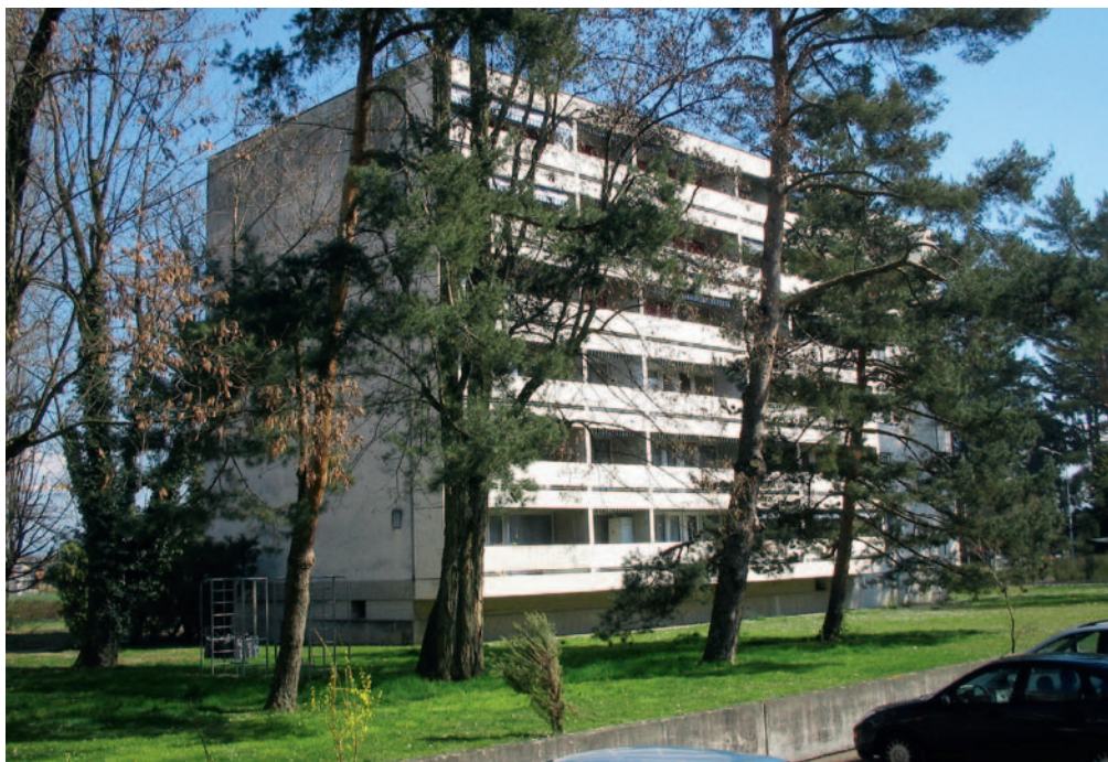
L'immeuble de la Casanostra Verein à Bienne.
