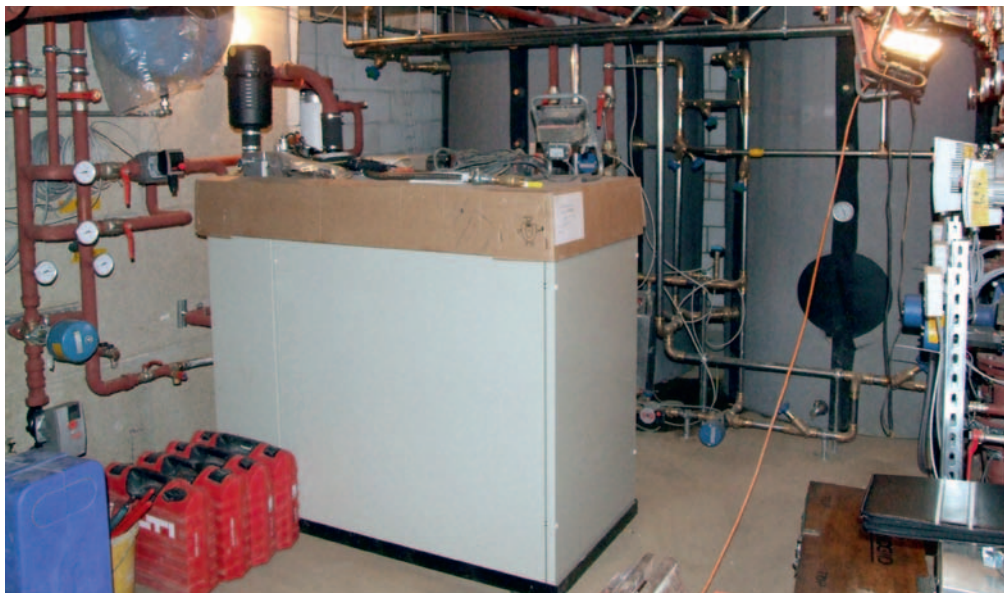
Vue de la salle technique avec au centre le bloc de cogénération. @ DOMO-Energie
