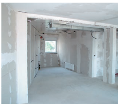
Les 3 étapes de l'installation d'un système de ventilation à double-flux, similaire à ce qui n'a finalement pas été réalisé dans l'immeuble Varnoz 2-4: 1) à gauche, on voit le tuyau principal vertical qui sera ensuite masqué dans le hall d'entrée; 2) au centre, on voit encore la structure de ventilation qui sera cachée par un faux plafond; 3) à droite, le faux plafond qui cache la structure de distribution, dont on ne distingue plus que les grilles amenant l'air dans les pièces. © mcb architectes/DR
