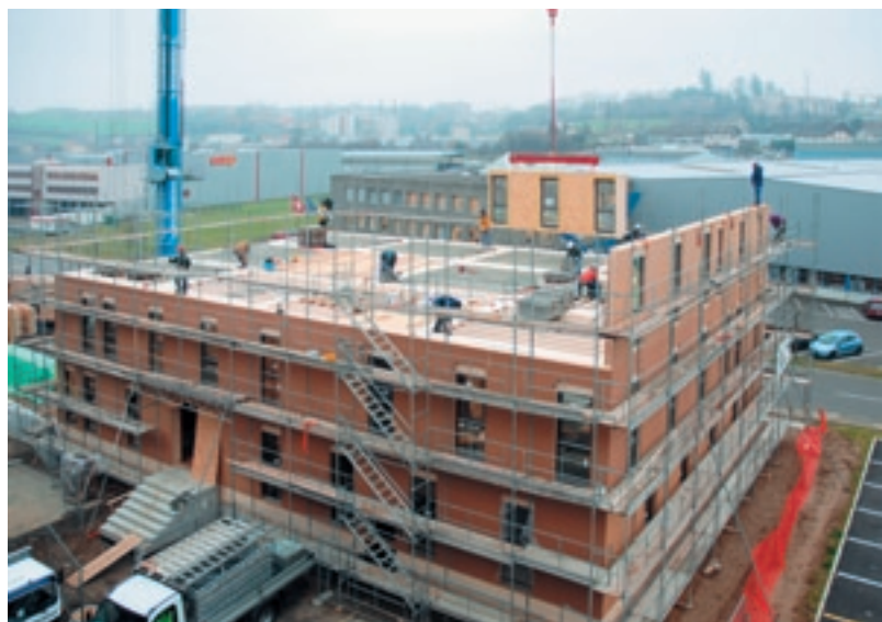
Montage des parois du troisième niveau.
