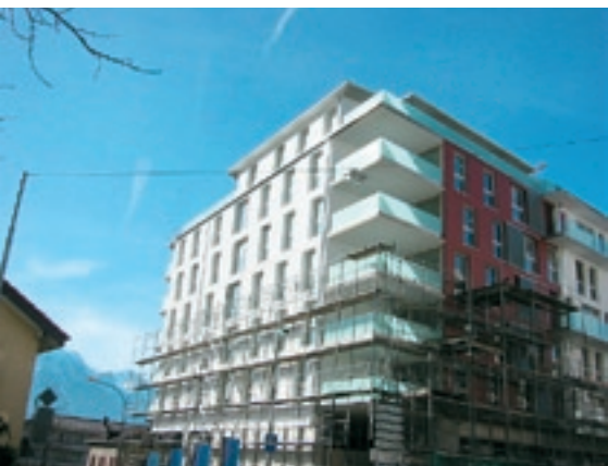
L'immeuble en construction à Clarens (VD).
