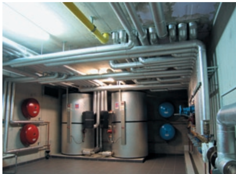
Vue générale des boilers d'eau chaude, des vases d'expansion et de la batterie de distribution avec départ en nappe.
