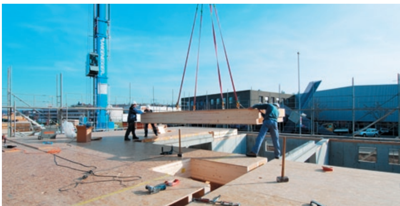
Montage de la dalle du rez-de-chaussée.
