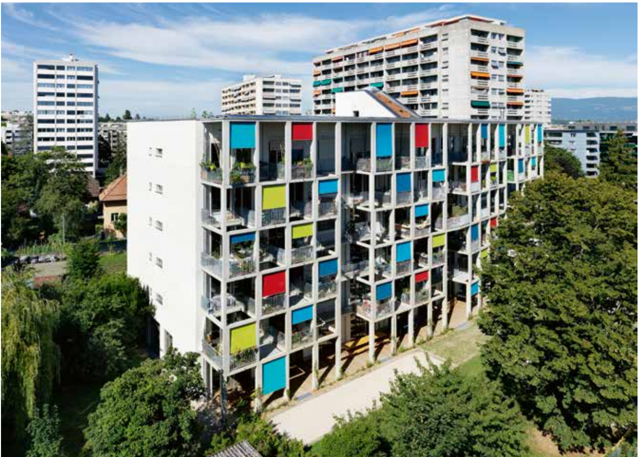
Les livings donnent sur le Sud. Les espaces laissés entre les balcons assurent un supplément de luminosité aux appartements. Annik Wetter/DR
