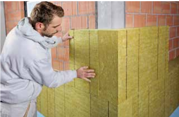
Pose des panneaux d'isolation contre un mur extérieur. © Flumroc
