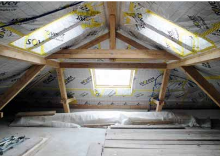
Les panneaux d'isolation sont fixés sous la charpente. © Lutz Architectes, Givisiez
