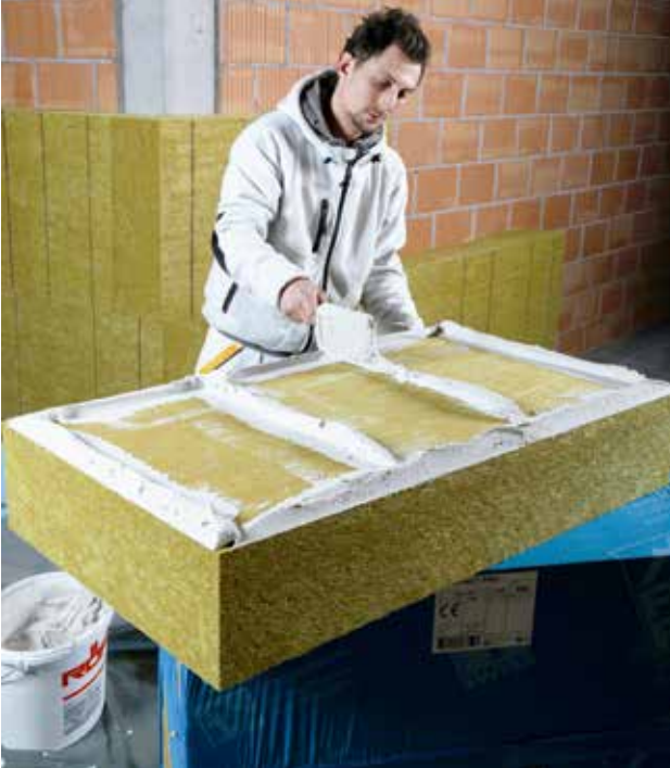
Préparation de la surface du panneau avec de la colle spéciale. © Flumroc
