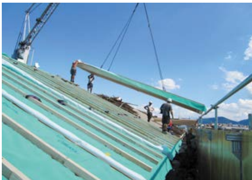
Pose d'un élément préfabriqué de toiture
