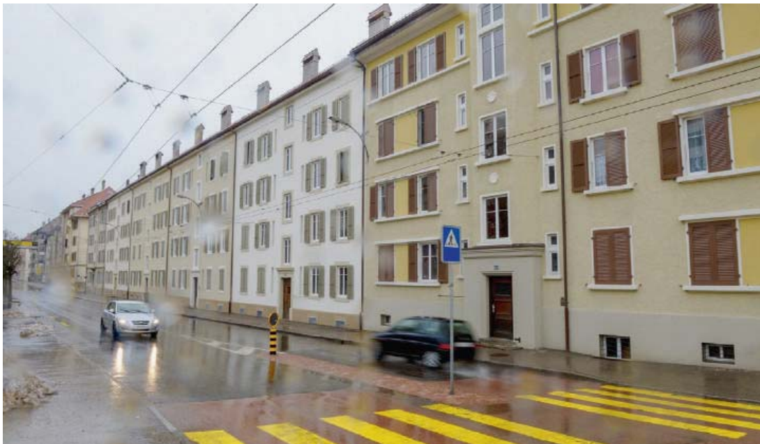
Les immeubles de la rue Numa-Droz 175 à 183 appartenant à la Ville et rénovés gardent encore des loyers abordables. CHRISTIAN GALLEY
