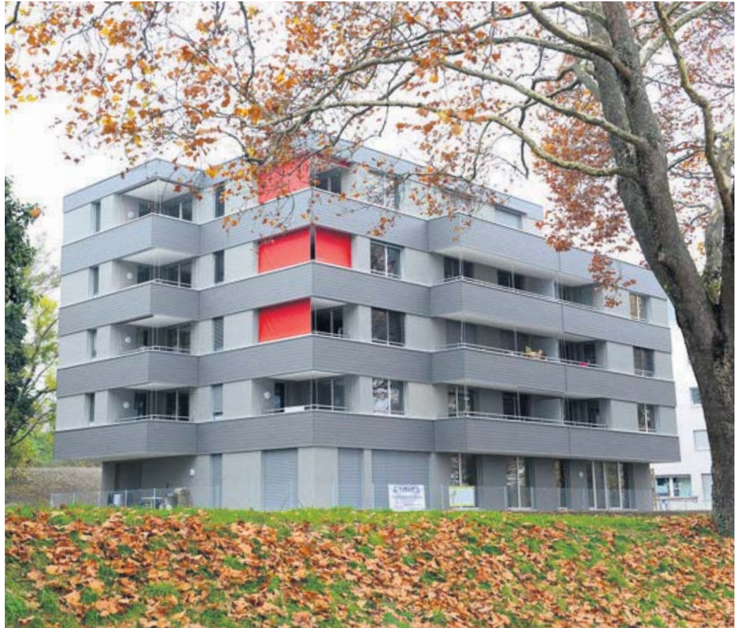
La Commune de Morges a inauguré récemment deux bâtiments à l'ouest de la ville. Sur les 26 appartements réalisés, la moitié est destinée à des locatifs à loyers abordables. PH. MAEDER
