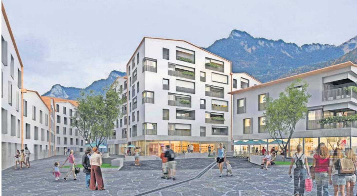
Le bâtiment le plus haut du complexe, qui comptera sept niveaux, culminera à 21 mètres de hauteur. © LEMANARC SA
