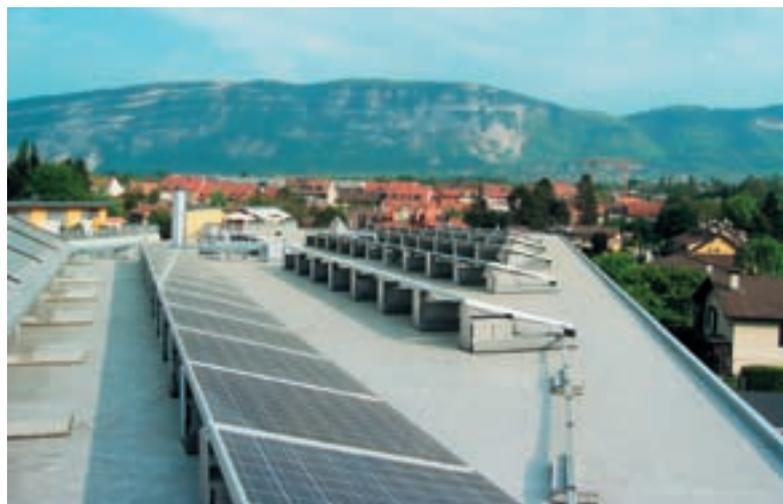
*Les panneaux photovoltaïques installés sur la toiture. On devine à gauche les panneaux solaires thermiques qui assurent la totalité de la production d'eau chaude en ce mois d'avril 2007 très doux.*
